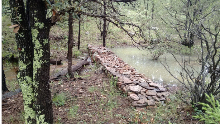
Figura 3. Obras de conservación de suelo en la región de Bocoyna, Chihuahua.
